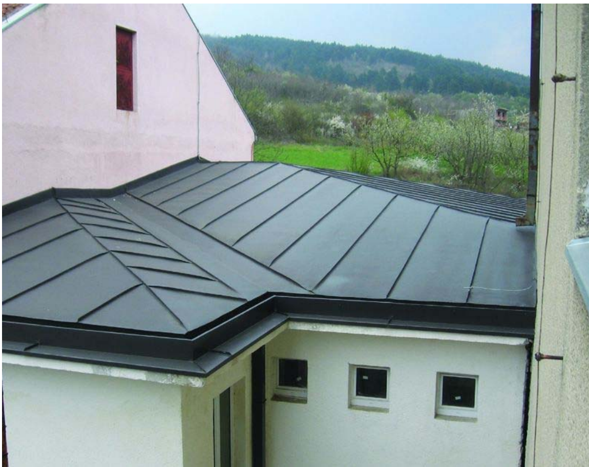
Изглед крова после реконструкције
